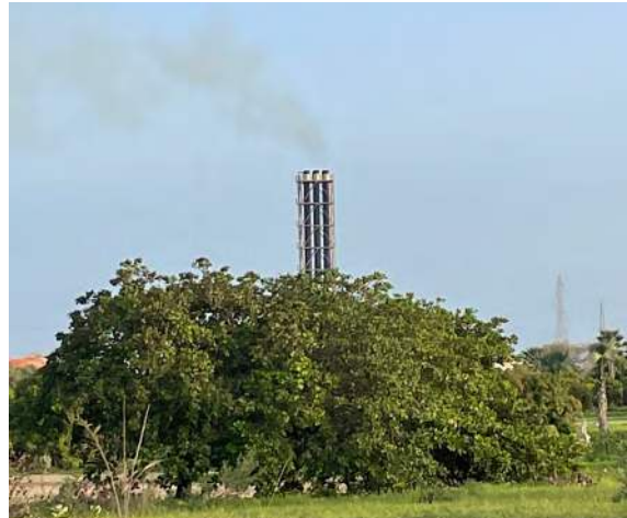
Centrale électrique de Tobene avec émissions, près du parc éolien
